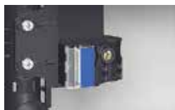
Клемник «нейтраль» просто розділити для підключення пристрою диференціального захисту
